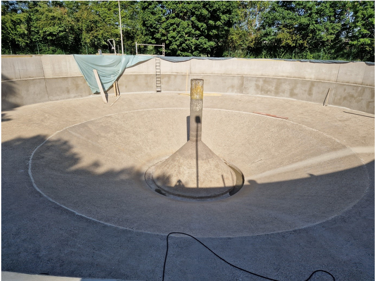
Aufnahme des RÜB Niedermendig nach Abschluss der Betonsanierungsarbeiten.
