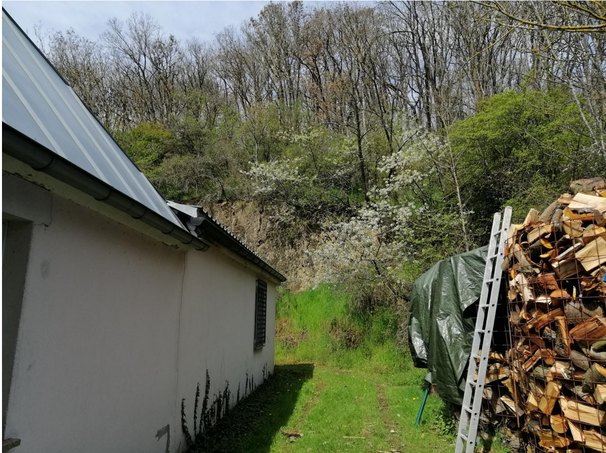
Abb. 8: Bestandsgebäude mit anschließender Felswand und Waldrand
