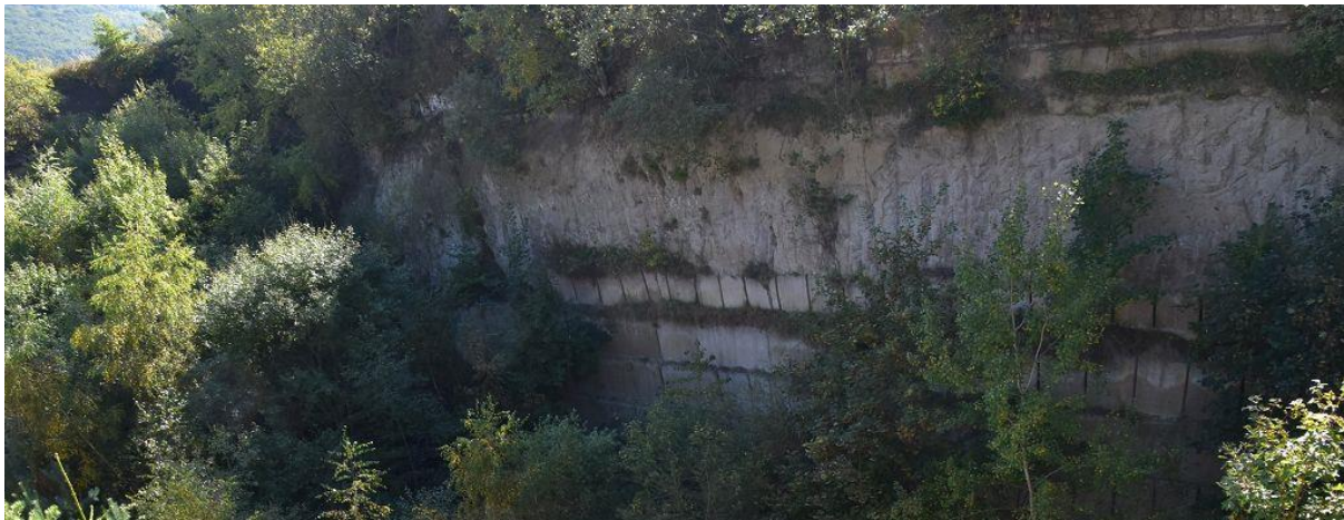
Abbildung 1: Südliche Betriebsböschung des Tuffsteintagebaus Ettringen 51.
