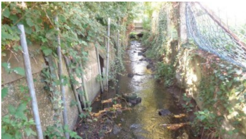
Foto 2: Bereich In den Mühlwiesen 12 und 12a (gegen Fließrichtung)
